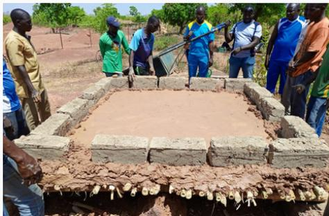
Après la pose de la dalle, placez une première couche de briques et ajustez de sorte à avoir une dimension intérieure de 2x2m. Liez ensuite les briques avec de l'argile.
