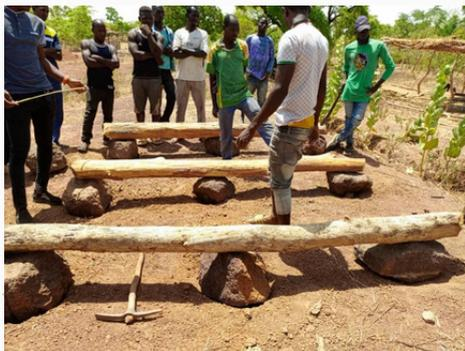
Réalisez des petits trous d'ancrage et déposer les 9 pierres espacées de 1,25 m. Les pierres sont déposées au niveau des 4 angles, au milieu de chaque côté et au centre de la structure du GTA.
