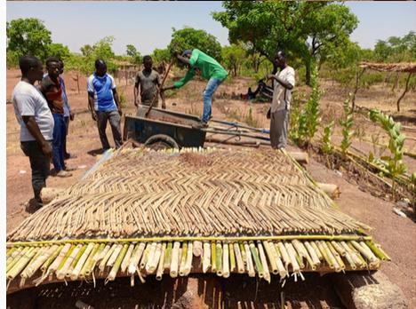
Mettez une petite couche de béton (mélange de terre gravillonneuse). Par la suite, ajoutez la terre préalablement préparée. L'épaisseur de la dalle ne doit pas excéder 15 cm.
