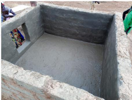
Cette étape marque la fin du premier compartiment. Bétonnez le contour de la porte. La deuxième dalle est faite aussi de bois de traverse et de palissade liées entre elles par du fil d'attache, le tout recouvert d'argile.
