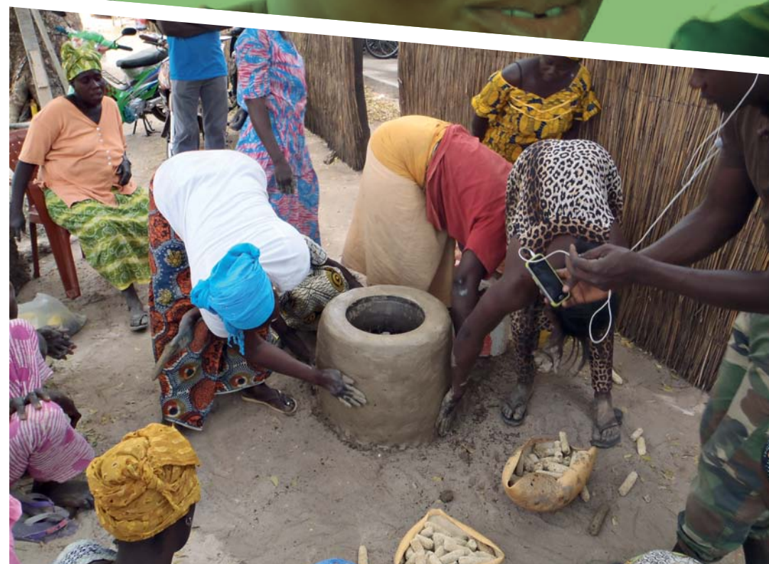
Construction d'un foyer amélioré
